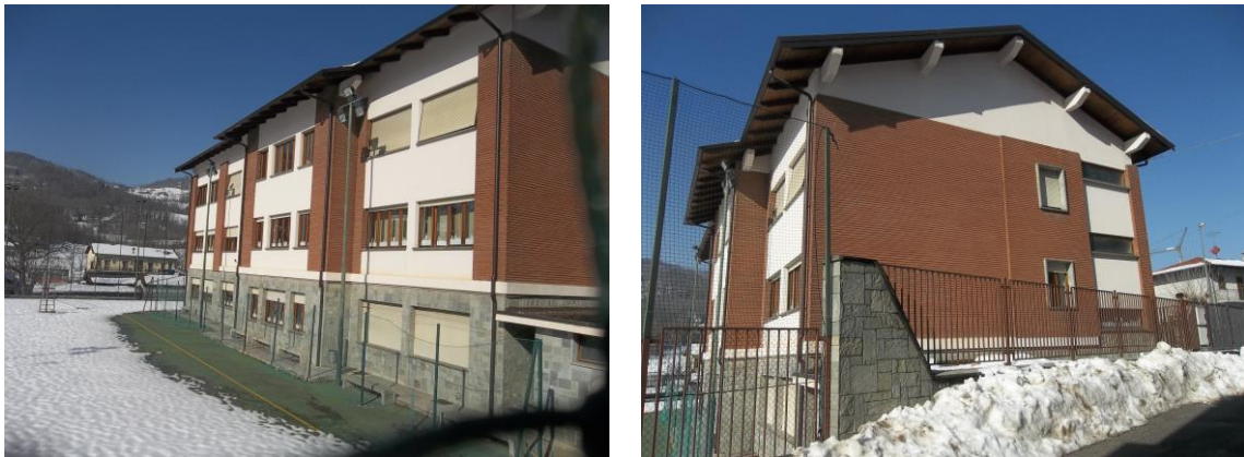
Viste del fabbricato: ingresso lato sud ed est
