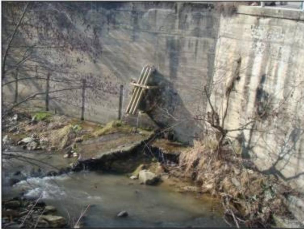
*Foto 1: fenomeni di erosione localizzata che interessano il cordolo di fondazione del muro di sponda a monte del ponte su Via Circonvallazione*
